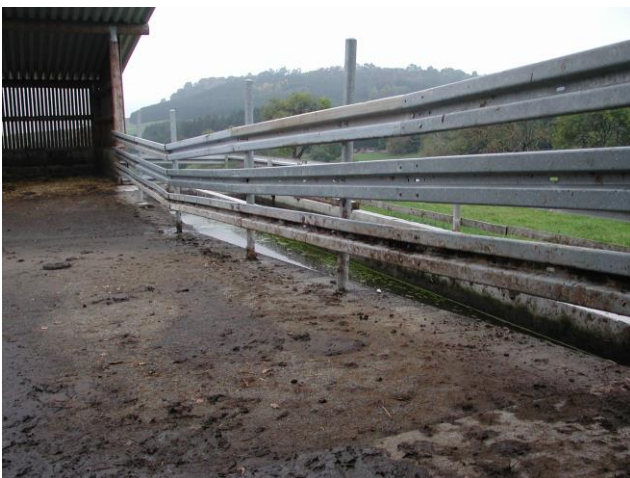
Bild 5: Die Entwässerung und Reinigung eines Laufhofes wird durch Gefälle und einen außen liegenden Abwurf unterstützt.
