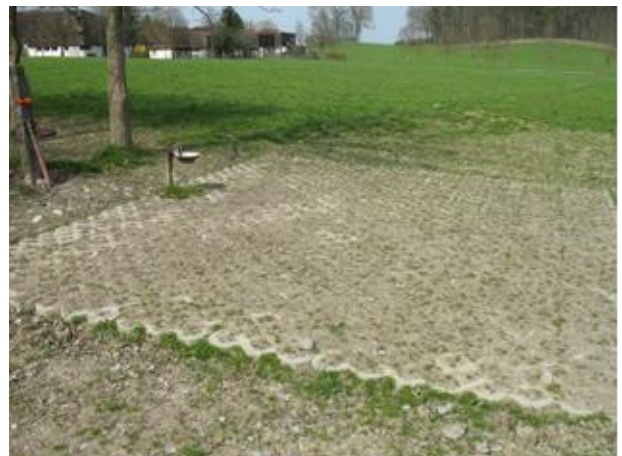
Bild 6: Beispiel für Gitterelemente aus Kunststoff zur Befestigung von temporär genutzten Laufhöfen, Weideein- und -austriebsbereichen sowie Futter- oder Tränkestellen.
